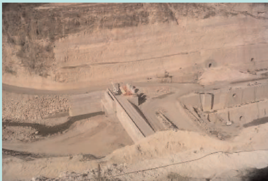
Fig. 32. Presa de El Zapotillo. Ataguía para el desvío del río Verde y losa de prueba.
