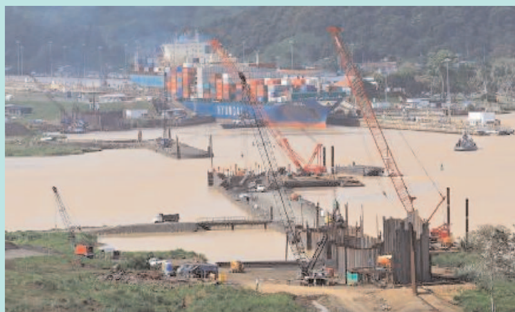
Fig. 29. Presa de Borinquen 1E (PAC-4). Ejecución de los cofferdams.
