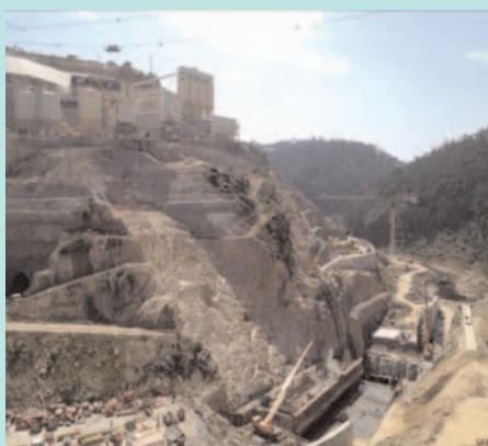
Fig. 19. Presa de Ribeiradio. Aspecto de la excavación e inicio del hormigonado.
