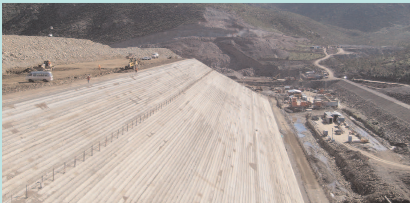
Fig. 9. Formación del talud aguas arriba con hormigón bordillado para apoyo de la pantalla.
