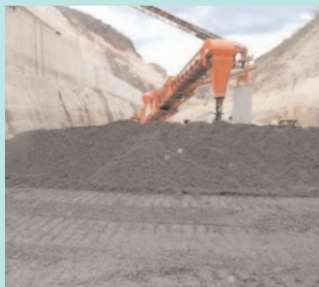
Fig. 33. Presa de El Zapotillo. Puesta en obra del hormigón compactado.
