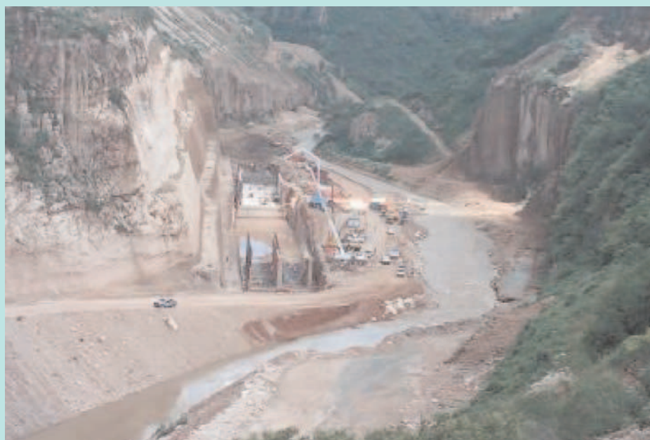
Fig. 30. Presa de El Zapotillo. Vista general de la presa y ejecución del canal de desvío del río.
